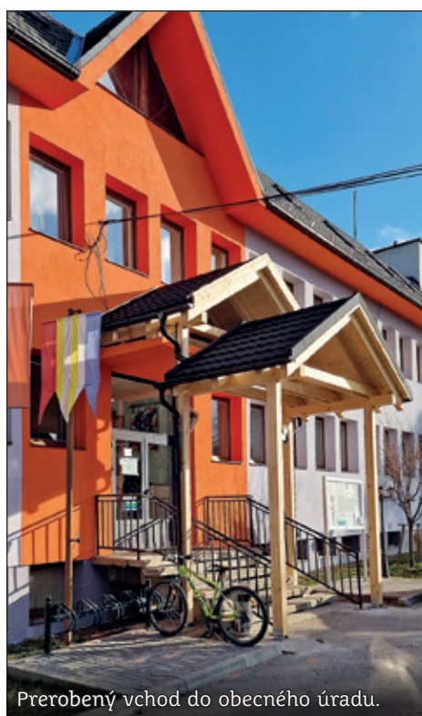
Zateplenie obecného úradu a kultúrneho domu.
